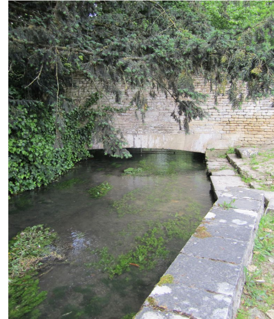
Amblie – Lavoir Rue des Moulins Sur la Thue
