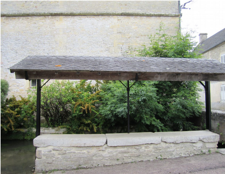
Amblie – Lavoir Rue des Moulins Sur la Thue
